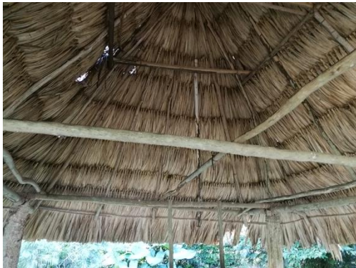
Fig. 2: Cambio de estructura y cubierta final del bungalow No. 4 debido al mal estado que actual posee.
