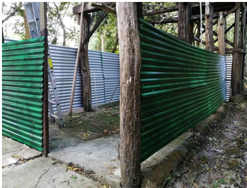
Fig. 3: Remozamiento del cerramiento vertical de la ducha del Sitio Arqueológico Nakum debido al mal estado del cerramiento anterior.
